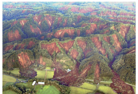
写真-1. 9月5日台風21号の雨で表層の火山灰や砂の重みが増し表層崩壊（北海道新聞社）
